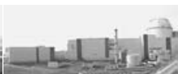
③3号道路より
