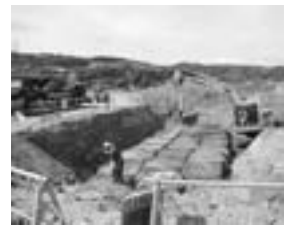
道路補強材撤去工事(布団籠等)
