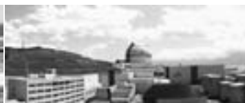
②2号機タービン建屋屋上より
