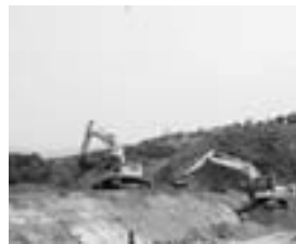
構内緑化工事
