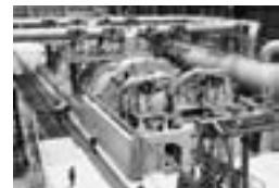
蒸気タービン初通気 回転上昇試験状況
