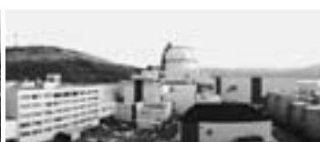
②2号機タービン建屋屋上より
