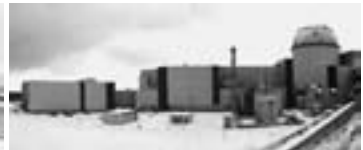
③3号道路より
