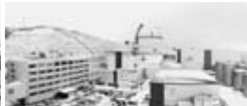
②2号機タービン建屋屋上より
