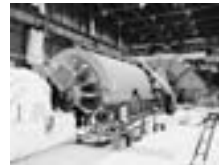
発電機内配管フラッシング状況
