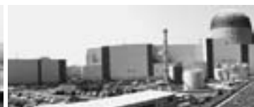
③3号機道路より
