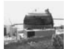
原子炉建屋トップドーム防水塗装工事状況
