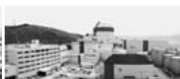
②2号機タービン建屋屋上より
