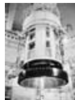
原子炉容器上蓋吊込み状況
