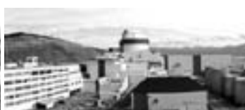
②2号機タービン建屋屋上より
