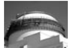
原子炉建屋 トップドーム 防水塗装工事状況
