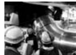
原子炉冷却系統設備耐圧試験状況 (蒸気発生器管台部分)
