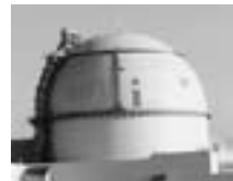
原子炉建屋トップドーム防水塗装工事完成状況
