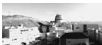
②2号機タービン建屋屋上より
