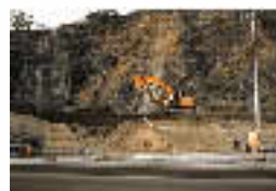
埋立地造成工事法面整形状況
