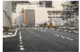
構内道路5次工事 3k道路完成状況
