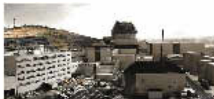
②2号機タービン建屋屋上より
