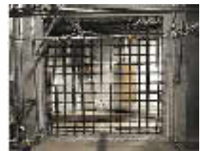
原子炉補助建屋仮開口閉鎖工事 鉄筋組立状況
