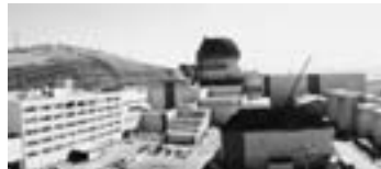
②2号機タービン建屋屋上より
