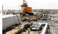
放水ビット西側3k 道路路床・路肩整正 工事状況
