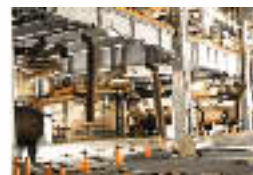
タービン建屋T.P. 17.8m 低圧給水加熱器芯出し・調整状況
