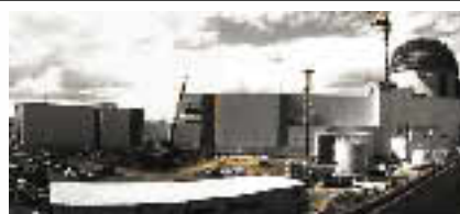
③3号機道路より
