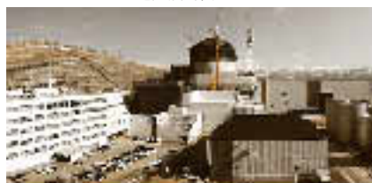
②2号機タービン建屋屋上より
