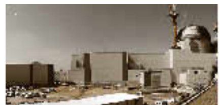
③3号道路より
