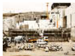
ダクト設備工事 放水ビット(上部工) コンクリート打設工事状況
