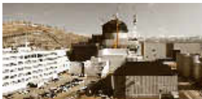
②2号機タービン建屋屋上より
