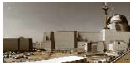
③3号道路より
