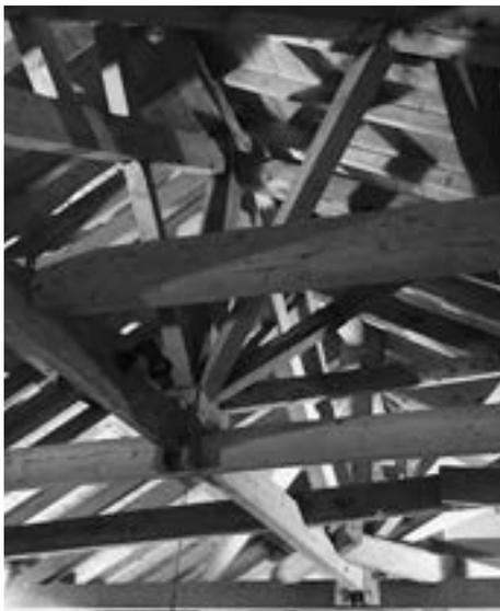
石蔵の屋根の骨組み(天井の梁)は、八方方杖合掌組工法と言われる特殊な工法で作られています。床の収納スペースを有効に使うために支柱を無くし、長い木材を使用せずに手頃なサイズの梁材をつなぎ合わせ「八方方杖工法」を組み込んだ様式で、大正時代の建築当時としての技術を結集した見事なできばえとなっています。
