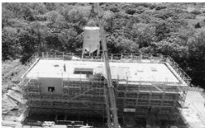
工事中的様子
