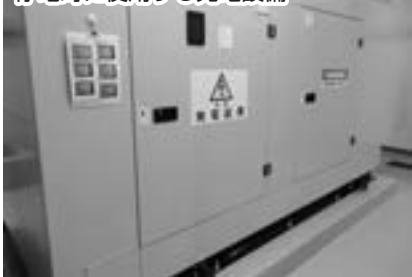
停電時に使用する発電設備
