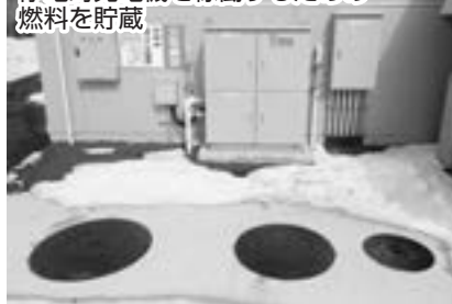
停電時発電機を稼働するための 燃料を貯蔵
