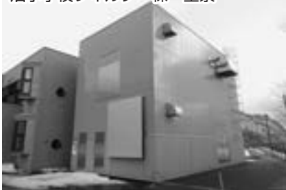
停電時に使用する発電設備
